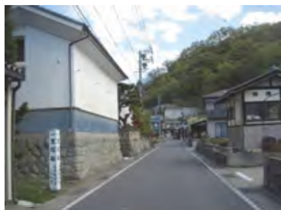
水害から家などを守るための家屋の工夫 [水屋] (千曲市・土口)
