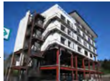
▲津波遺構「たろう観光ホテル」(岩手県宮古市) 東日本大震災時の津波で、2階まで柱を残して流失、4階まで浸水しました。 (写真提供：曾川剛志氏)
